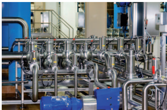
Maintenance préventive en IAA
